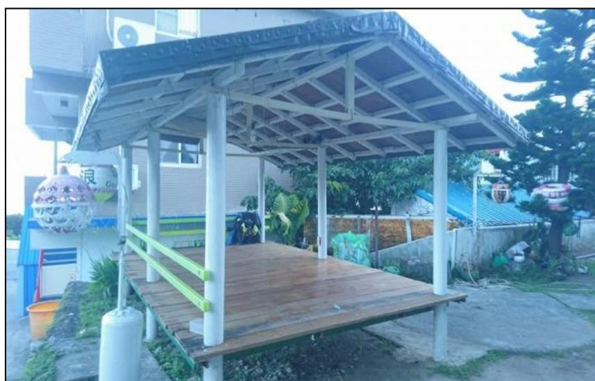
圖 6：新型涼台利用油毛氈作屋頂、水泥柱作樑柱
